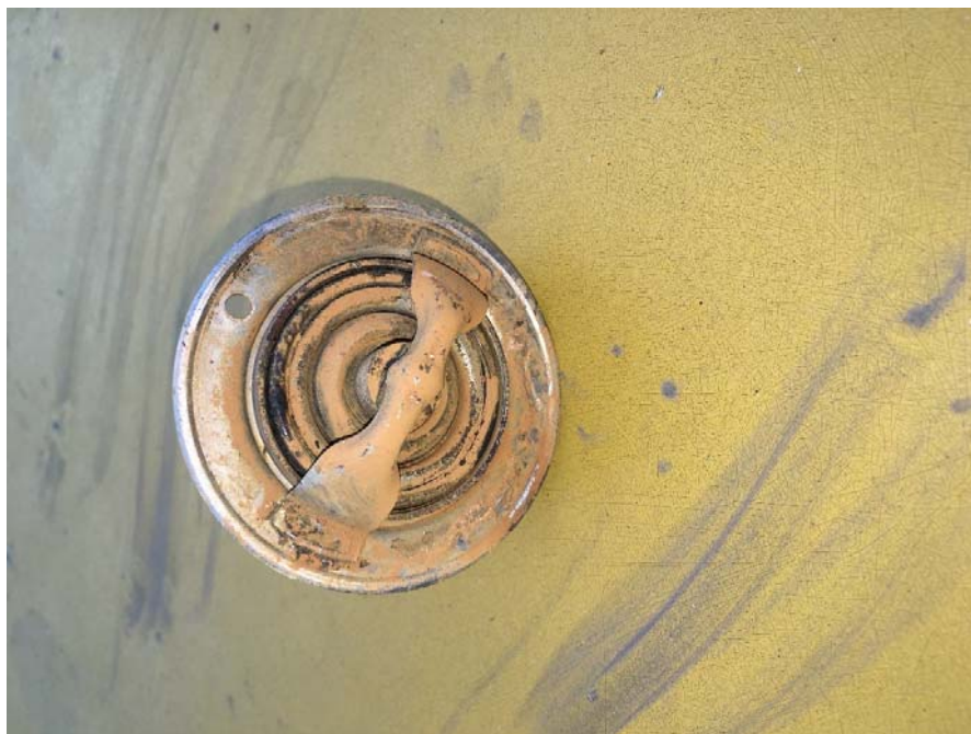
รูปภาพที่ 8 วาล์วน้ำเสื่อมสภาพ#
